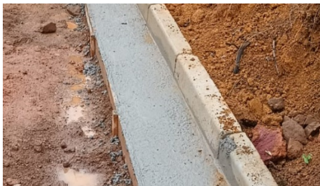
Figura 02. Forma de execução das sarjetas com auxílio de guia de madeira
