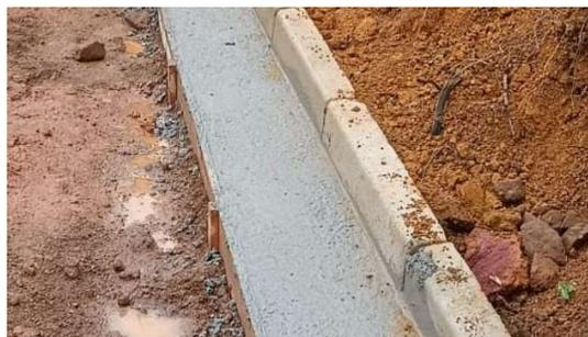
Figura 03. Modo de execução das sarjetas com forma lateral para precisão de largura e altura da mesma.
