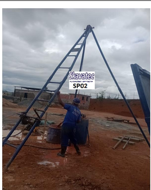
**Foto 2** - Equipamento de Sondagem em Operação
