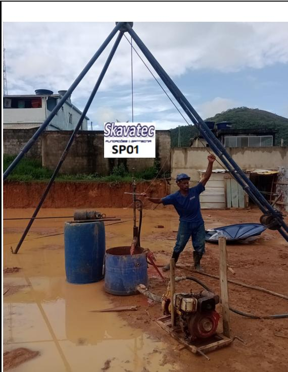
**Foto 1** - Equipamento de Sondagem em Operação
