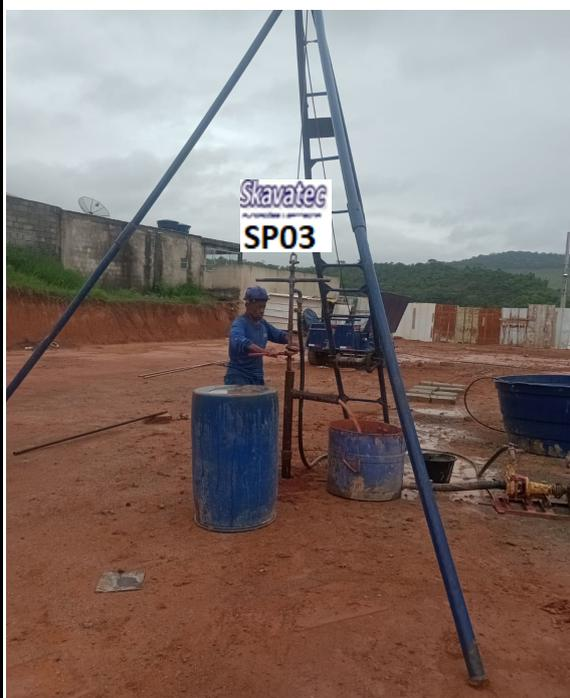
**Foto 3** - Equipamento de Sondagem em Operação
